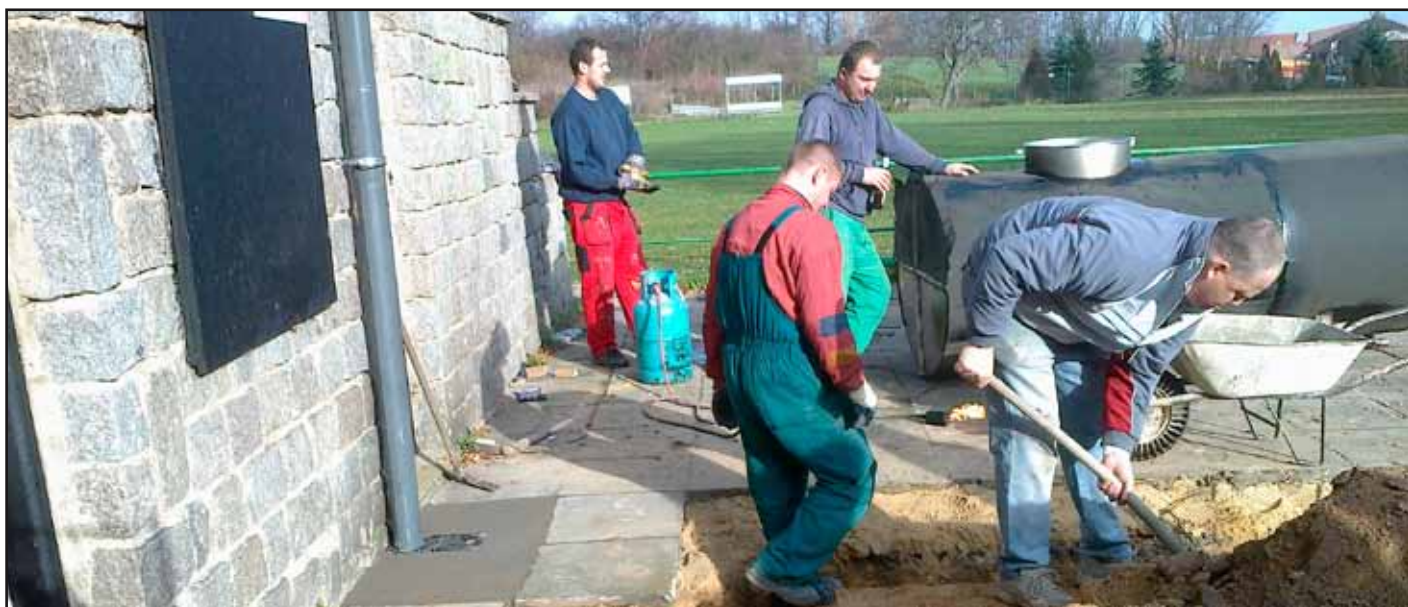
Výkop pro umístění potrubí
